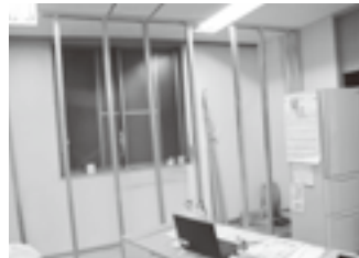
1階から4階まで西側の外壁撤去のために事務室内に仮囲いをされました。
