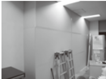
西側壁に仮囲いで仮の壁ができました。
