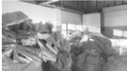
5階会議室の撤去作業。断熱材等のゴミが沢山出ています。
