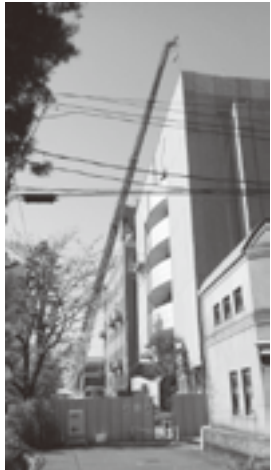
足場が組み上がり、ようやく工事が始まりました。
