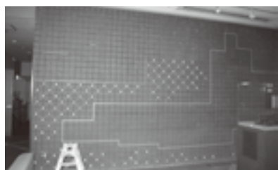
ロビーのタイルが浮いている箇所にエポキシ樹脂を注入されました。
