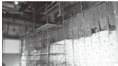
5階会議室の撤去作業。内部にも足場を組んで天井等を撤去されました。
