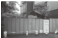
市・警察に連絡し通行止めに。裏側の駐車場も一部使用不可にして対応。
