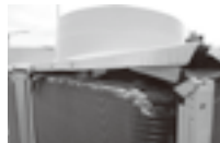
屋上エアコン室外機が破損。7台を交換、修理。
